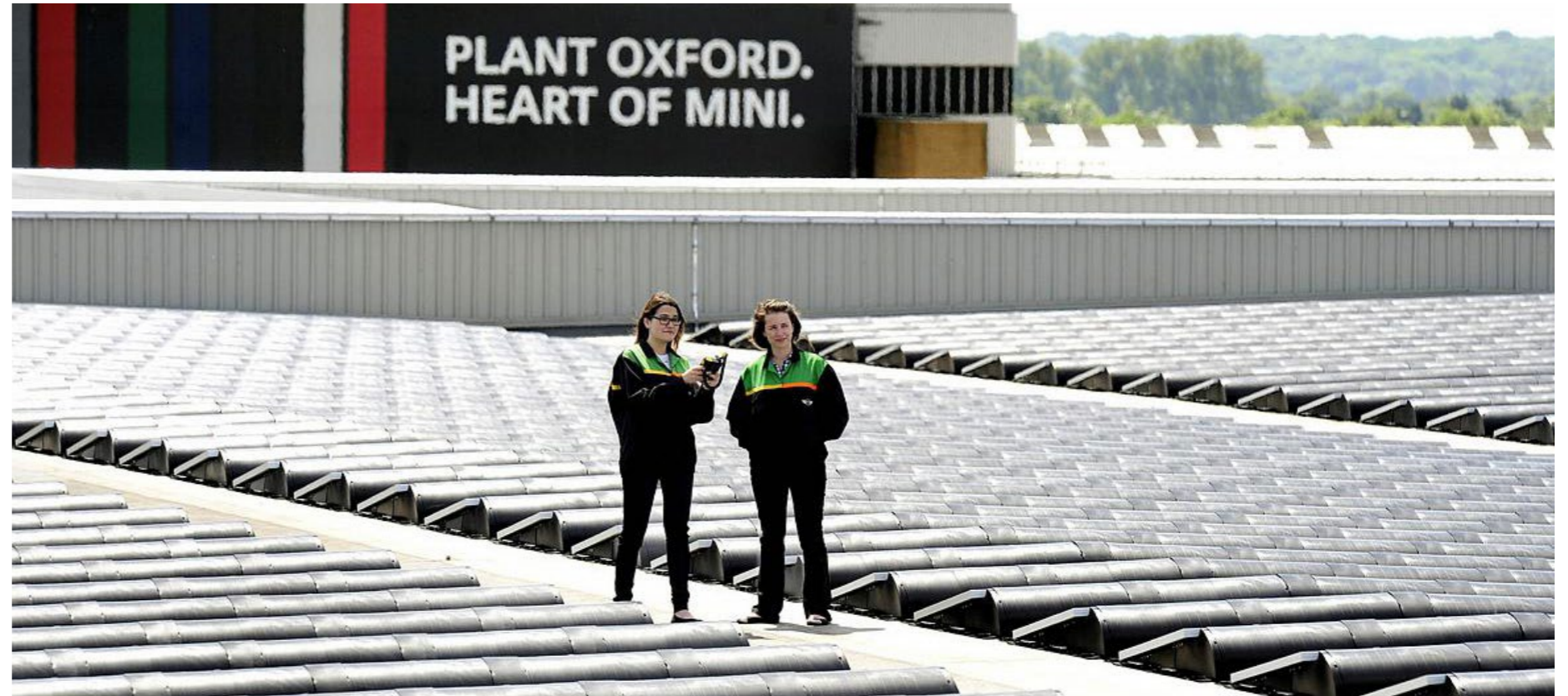
ERNEUERBARE ENERGIE FÜR DIE MINI PRODUKTION — Solaranlage im Werk Oxford
